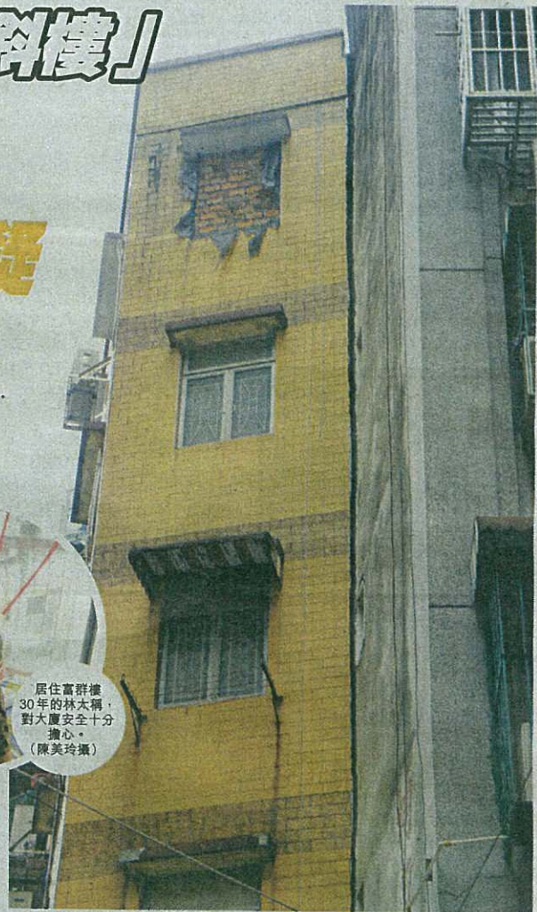
▲富群樓與均昌樓之間的巨大裂縫十分明顯，最闊處可塞入拳頭。(陳美玲攝)
